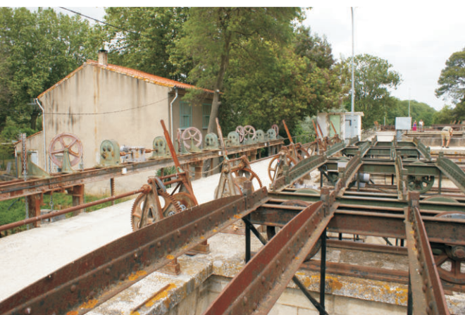
Libron – budowla przeciwpowodziowa
