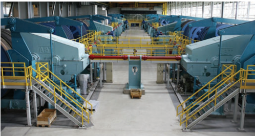
Kanał Centralny w Strépy Thieu. Maszynownia
