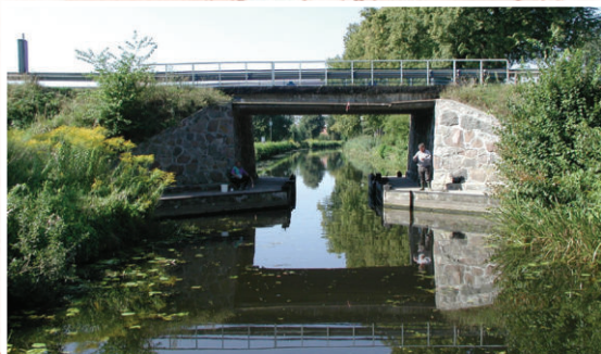
Wrota przeciwpowodziowe – Miłomłyn
