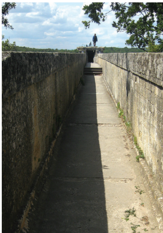
Przewód wodociągu w koronie mostu kanałowego
