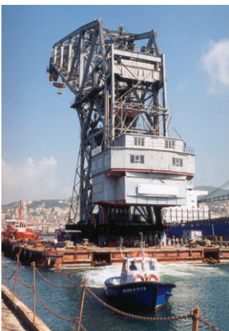
Dźwig Pływający „Heinrich”, 1915 (pierwotnie z napędem parowym)
