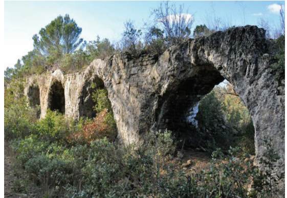
Nimes – inny most kanałowy wodociągu
