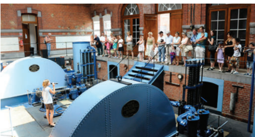
Kanał Centralny w Strépy Thieu. Maszynownia
