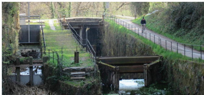
Śluzy Kanału Paderno
